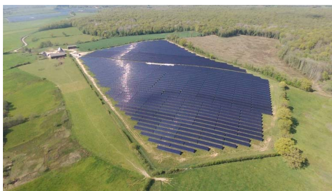
Figure 2 : parc photovoltaïque de Verneuil - Photosol
