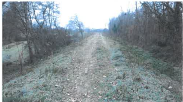
Photo 4 : levée de Caqueray avec talus défrichés
