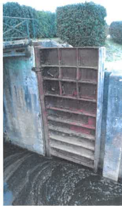
Photo 2 : porte de garde
