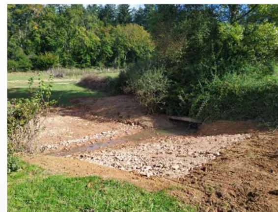
Photo 4, après travaux - P13, passage à gué restauré
