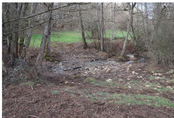
Photo 5, après travaux - passage à gué à restaurer
