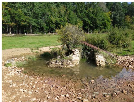
Photo 2, après travaux – P14, passage à gué et ancien lavoir restauré
