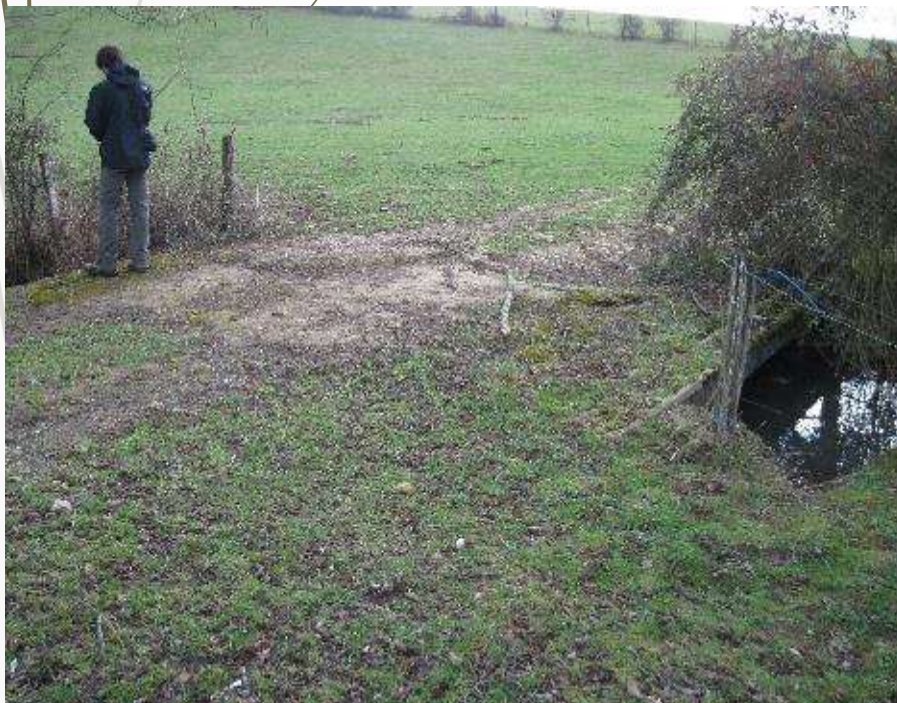
Pont avant les travaux
