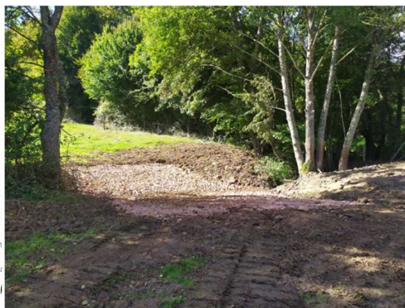
Photo 6, après travaux - passage à gué restauré
