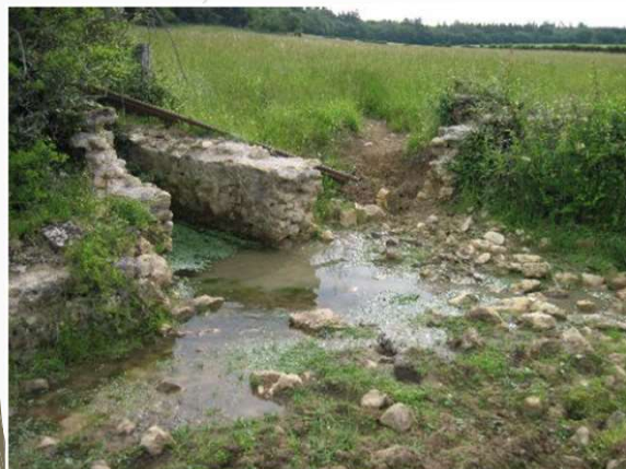
Photo 1, après travaux – P14, passage à gué et ancien lavoir restauré
