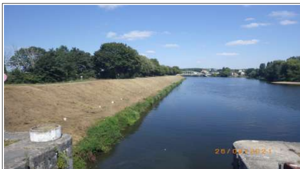
Levée de la jonction 3 ème section après fauchage
