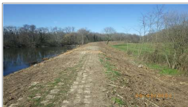
Levée de Caqueray après travaux de dé-végétalisation
