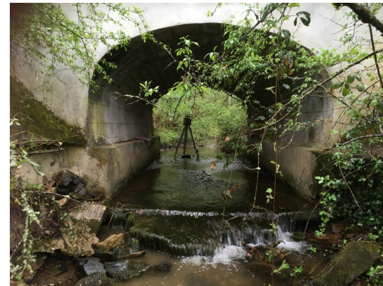
Pont à Sémelay
