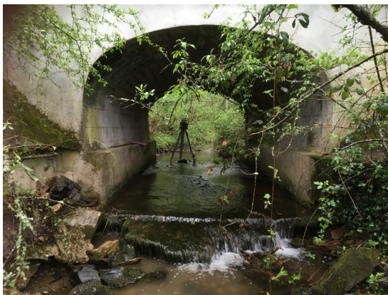
Pont à Sémelay
